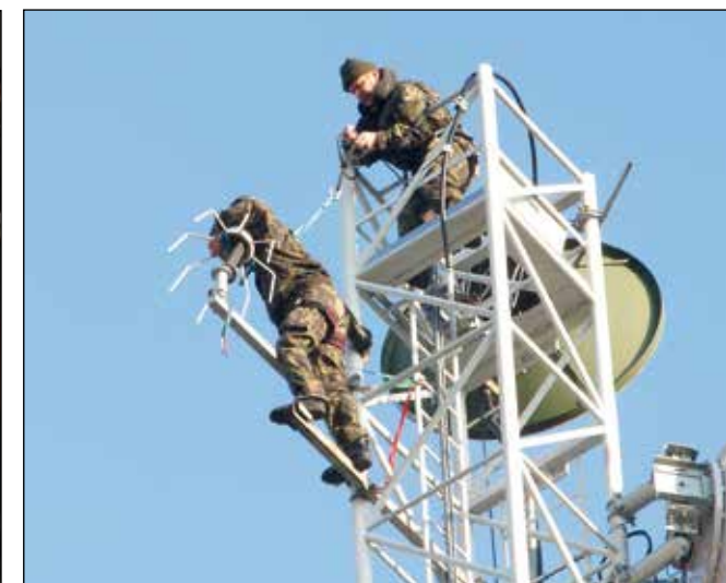
26. pVRPz – Opravna leteckých radionavigačních systémů
